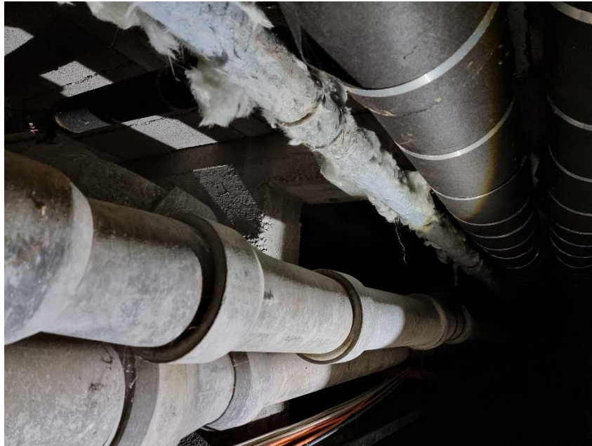
Foto 7: Ein altes Heizrohr das schon eine stark beschädigte Isolierung aufweist (Isolierung fast nicht mehr vorhanden).
