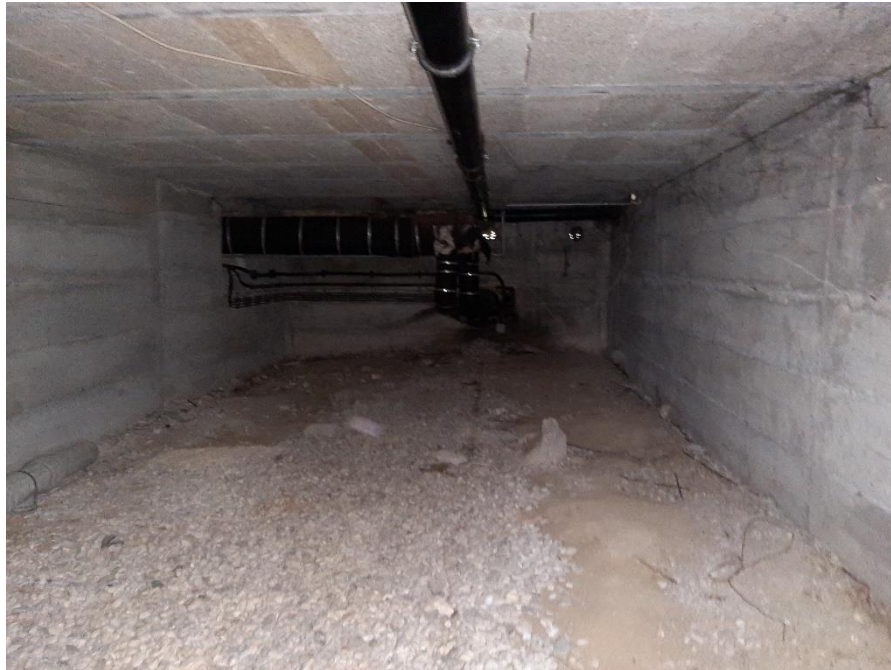
Foto 5: Großer Raum, Blick Richtung Süden.
