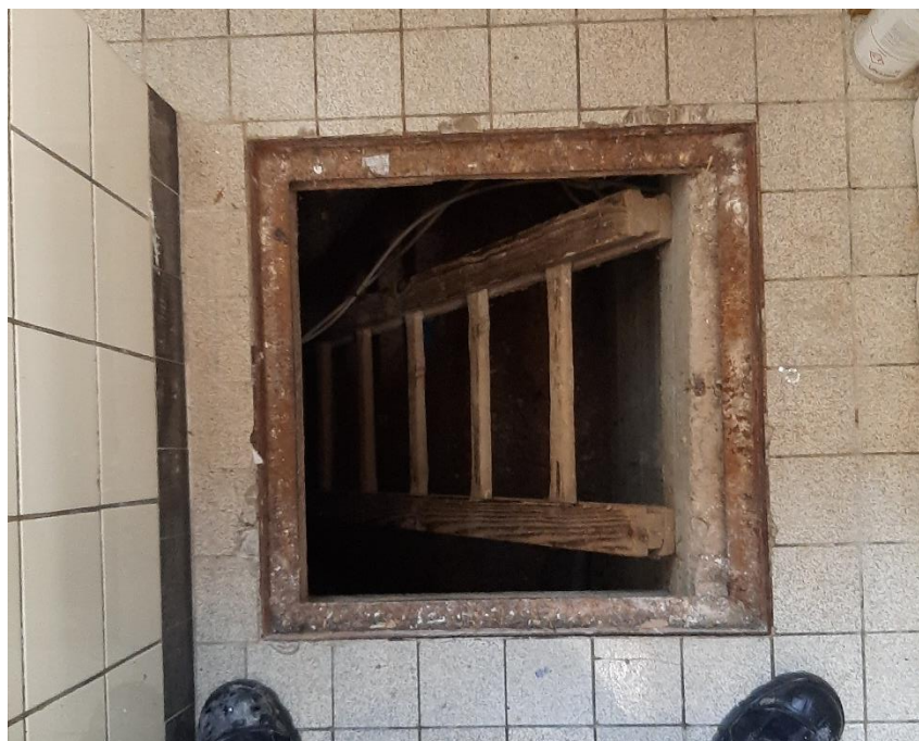
Foto 6: Geöffnete Eingangsklappe mit Zugangsleiter zum Kriechkeller.
