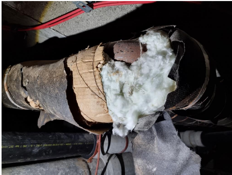
Foto 3: Zum Teil gedämmte und mit Pappe umschlossene Heizleitungen. Schadstoffverdacht: Alte KMF-Dämmung (KMF TRGS-521 bzw. Asbest TRGS-519), bitumenhaltige Pappe (PAK TRGS 551)
