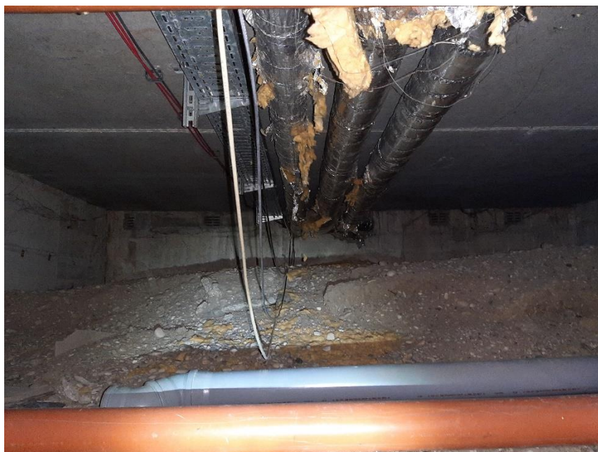
Foto 8: Durch die Tür gelangt man in den ersten von zwei Räumen. An der Decke befinden sich abgehängte und gedämmte Heizleitungen. Schadstoffverdacht: Alte KMF-Dämmung (KMF TRGS-521 bzw. Asbest TRGS-519)
