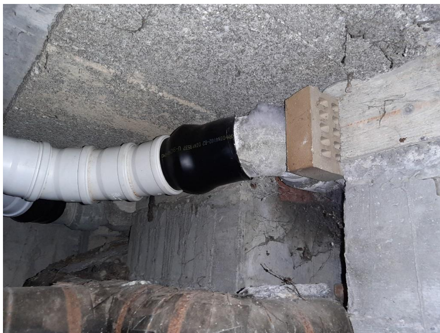
Foto 10: Anschluss eine zementhaltige Abwasserleitung an eine Kunststoffleitung Schadstoffverdacht: Asbesthaltige Zementrohre (Asbest TRGS-519)
