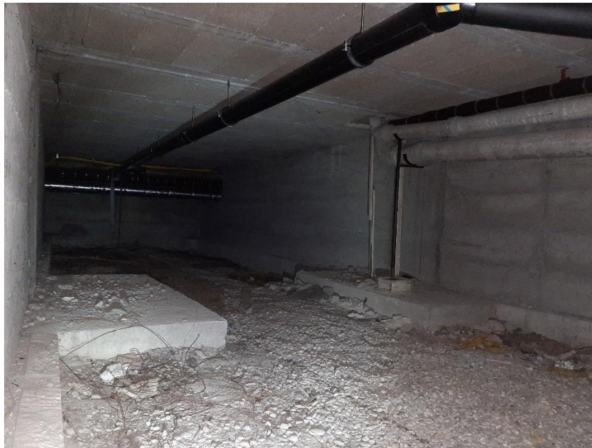
Foto 10: Ein weiterer großer ungenutzter Raum, Blick Richtung Süd-West
