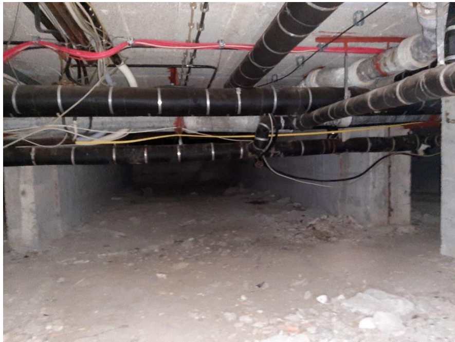
Foto 9: Übersichtsbild der zementhaltigen Abwasserleitungen und gedämmte Heizleitungen, Blick Richtung Süden
