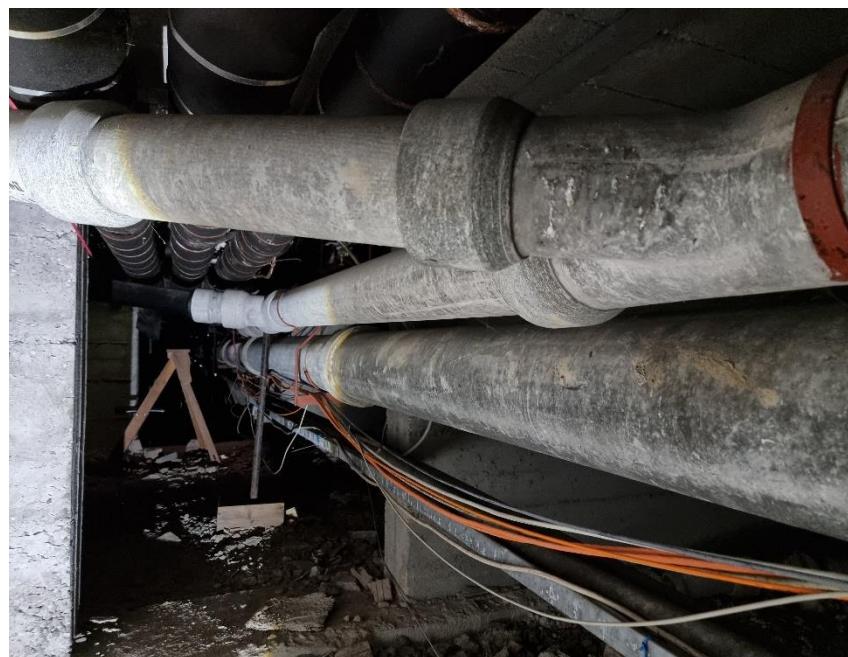
Foto 8: Anschluss einer Zementhaltigen Abwasserleitung an die Längsleitung, Blick Richtung Osten
