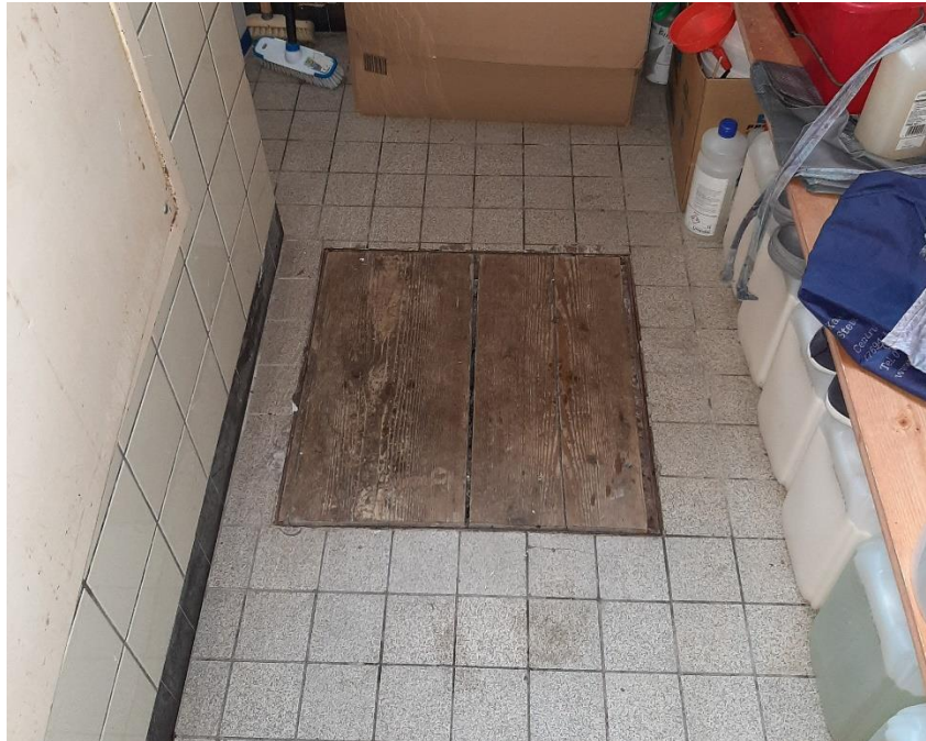
Foto 5: Zugang zum Kriechkeller (Holzdielenklappe), erreichbar über Gebäudeteil G, Raum 0.16
