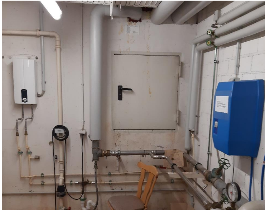
Foto 7: Zugang zum Kriechkeller durch eine kleine Türe im 1. Untergeschoss des Gebäudeblocks N (Raum -1.06)
