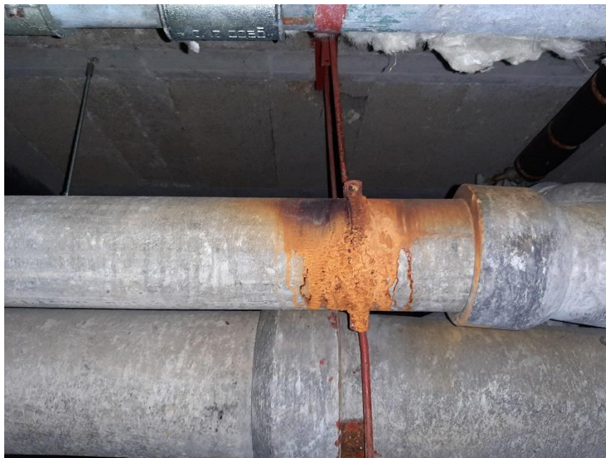
Foto 11: Zementhaltige Abwasserleitungen mit korrodierter Rohrschelle, Blick Richtung Süden.
