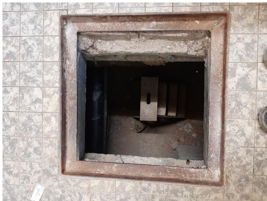
Foto 2: Geöffnete Eingangsklappe mit Zugangsleiter zum Kriechkeller.
