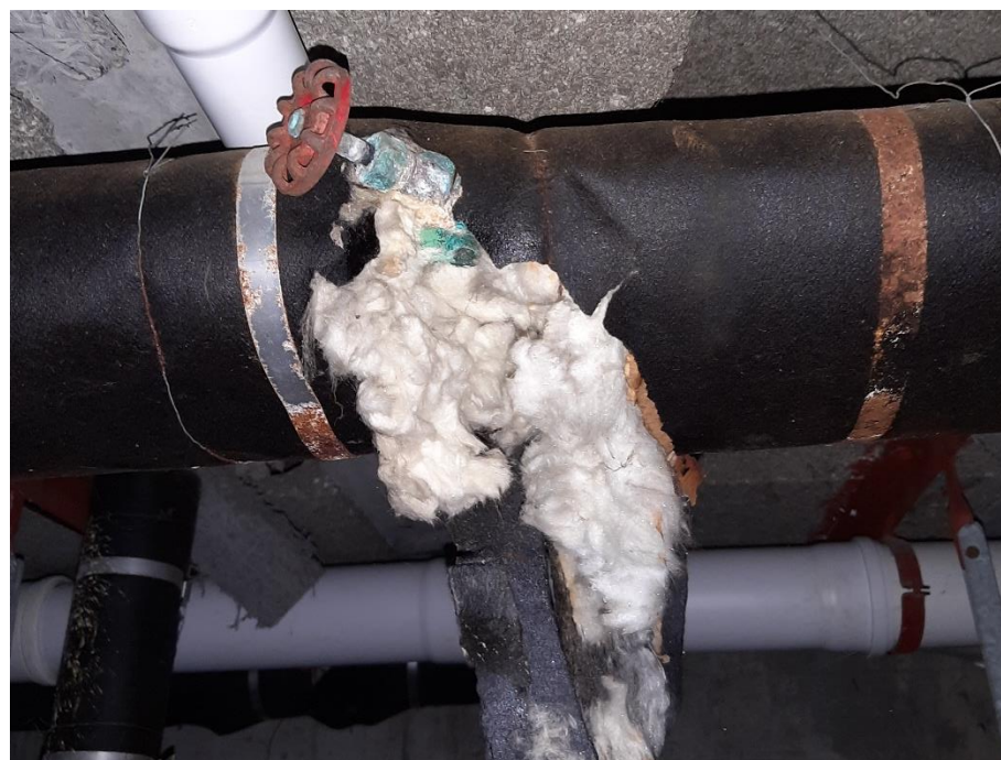
Foto 8: Anschlussventile einer gedämmten und in Pappe umschlossene Heizleitung. Schadstoffverdacht: Alte KMF-Dämmung (KMF TRGS-521 bzw. Asbest TRGS-519), bitumenhaltige Pappe (PAK TRGS-551)
