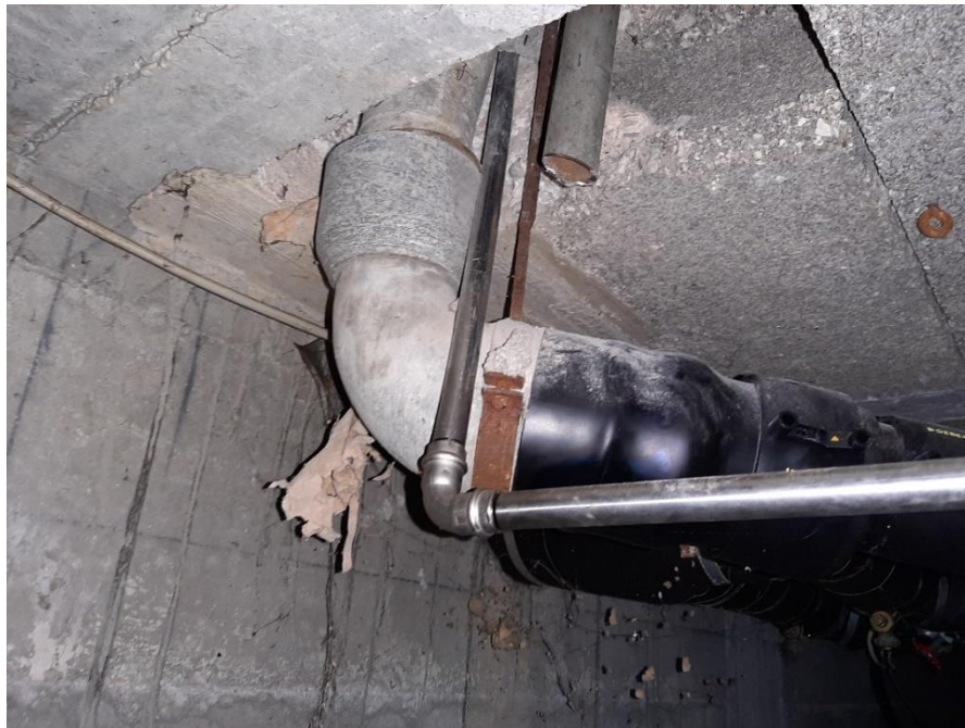
Foto 12: Abwasseranschluss ins Erdgeschoss. Schadstoffverdacht: Asbesthaltige Zementrohre (Asbest TRGS-519)
