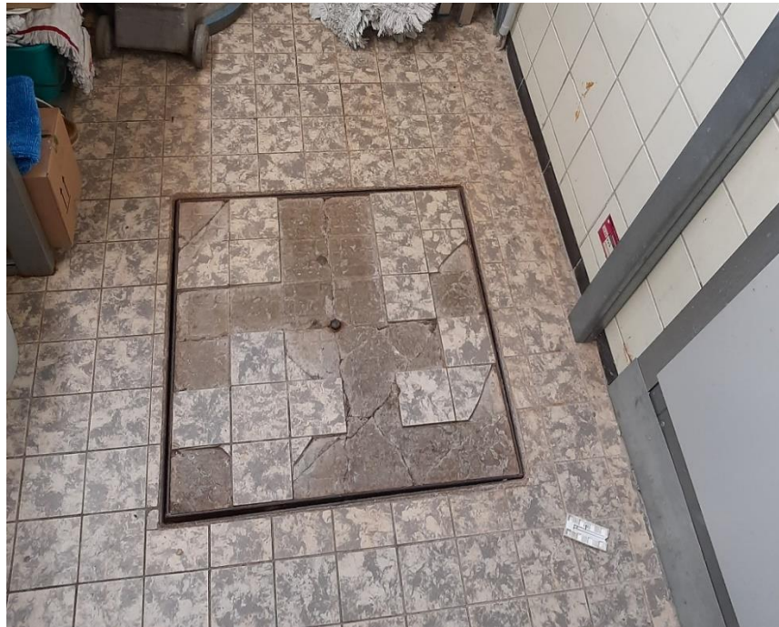
Foto 1: Zugang zum Kriechkeller (geflieste Eingangsklappe), erreichbar über Gebäudeteil H, Raum 0.02 Schadstoffverdacht: Fliesenkleber (Asbest TRGS-519)
