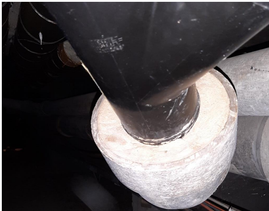
Foto 13: Anschluss einer Abwasserleitung (Kunststoffrohr) an Zementrohr, Blick Richtung Süden Schadstoffverdacht: Asbesthaltige Zementrohre (Asbest TRGS-519)
