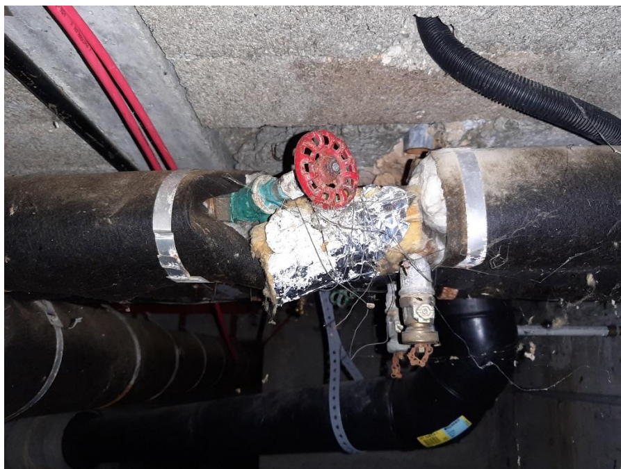
Foto 4: Anschlussventile einer gedämmten und in Pappe umschlossenen Heizleitung. Schadstoffverdacht: Alte KMF-Dämmung (KMF TRGS-521 bzw. Asbest TRGS-519), bitumenhaltige Pappe (PAK TRGS-551)
