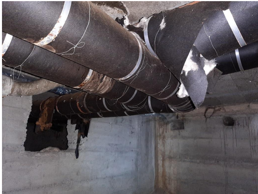
Foto 7: Gedämmte und mit Pappe umschlossene Heizleitungen. Schadstoffverdacht: Alte KMF-Dämmung (KMF TRGS-521 bzw. Asbest TRGS-519), bitumenhaltige Pappe (PAK TRGS 551)
