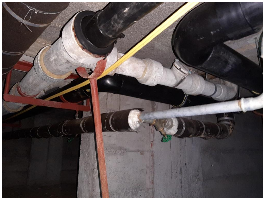
Foto 6: Anschluss Kunststoffrohr an zementhaltige Abwasserleitungen und einer darunterliegende Heizleitungen.
